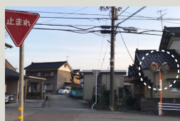
■ 増設後(左方向新設)
